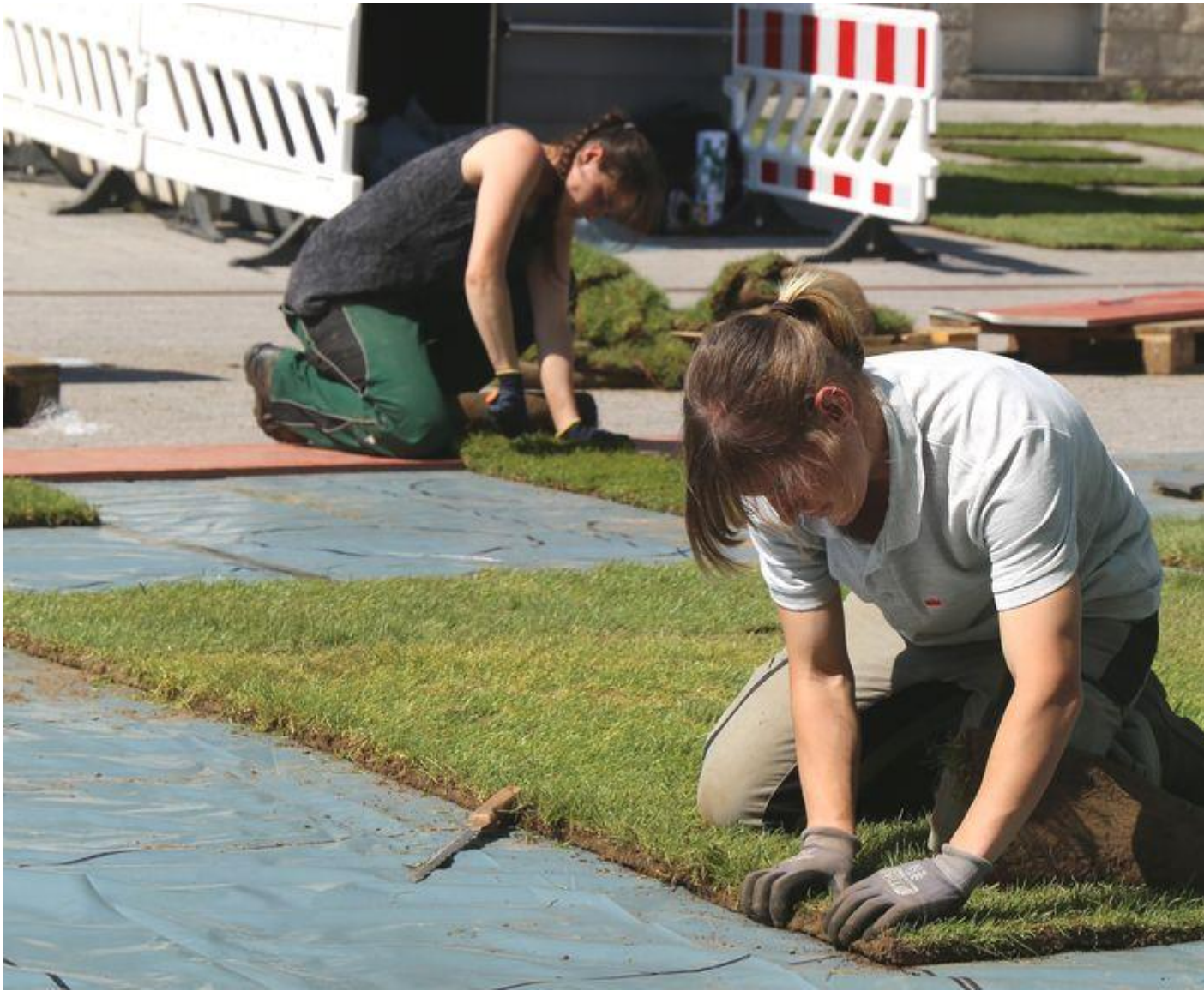
Die Mitarbeiter des Gartenamtes verlegen den Rollrasen vor dem Kulturspeicher
